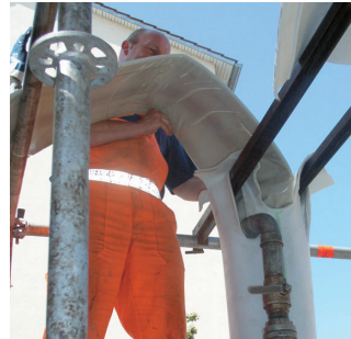
Einführen des Schlauches in das Kanalrohr.
