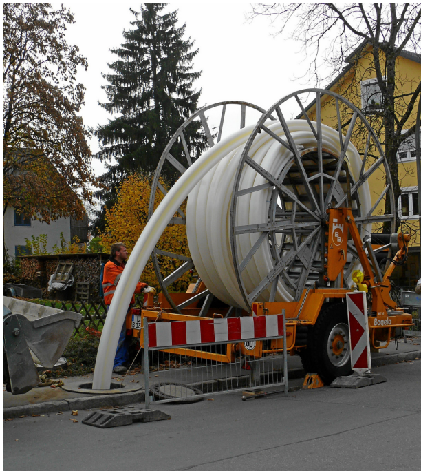
Einbau des Rohres in der Köchlinstraße
