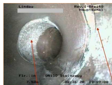
Bild 7a: Sekundärschaden
