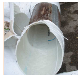
Bild 8: Fertiges „Rohr im Rohr“
